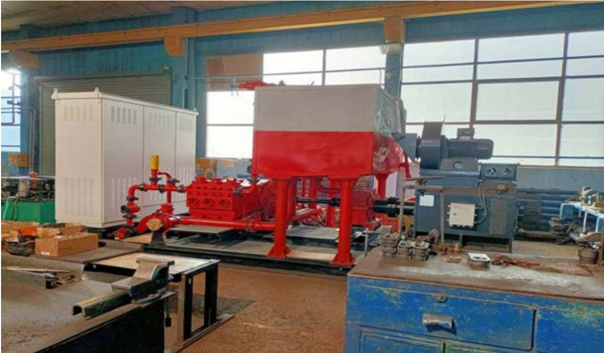
Fig 2.2- Instalatie de cimentare ansamblu vedere laterala
