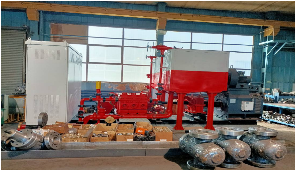
Fig 3- Instalatie de cimentare ansamblu
